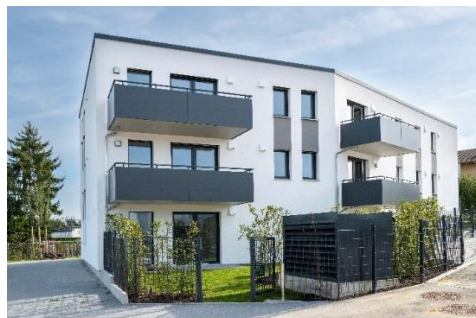
Aindling, Bussardweg 8 (Westfassade)
