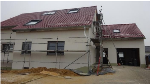
Neubau eines Wohnhauses im Landkreis
