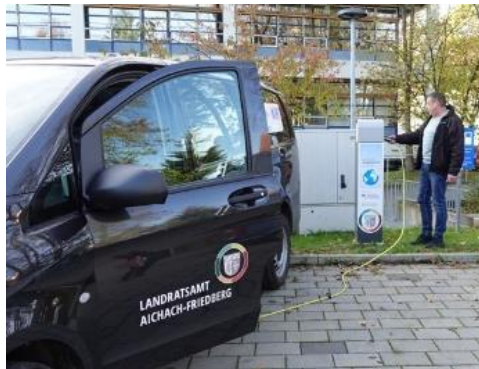
Abbildung 12: Ladesäule LRA, Quelle: LRA Aichach-Friedberg 2022
