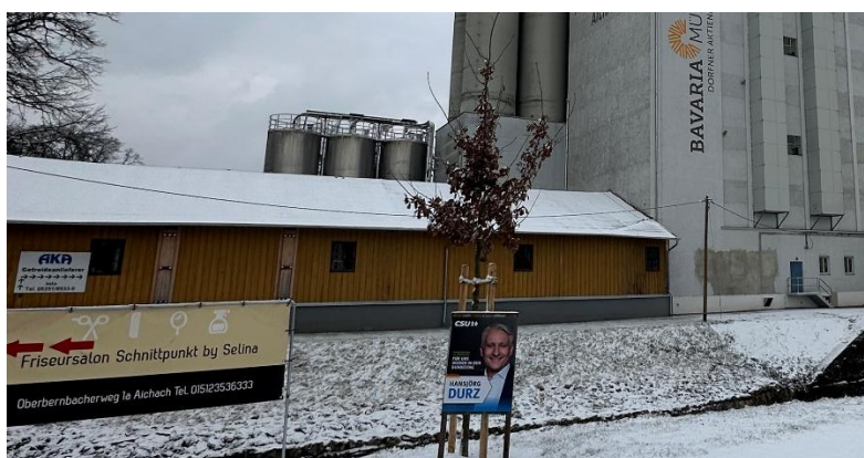
Abbildung 4: Mehlsacklager Ansicht West 14.02.2025
