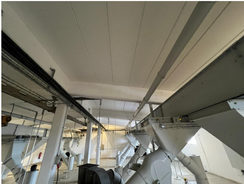
Abbildung 2: oberstes Geschoss Getreidesilo 14.02.2025
