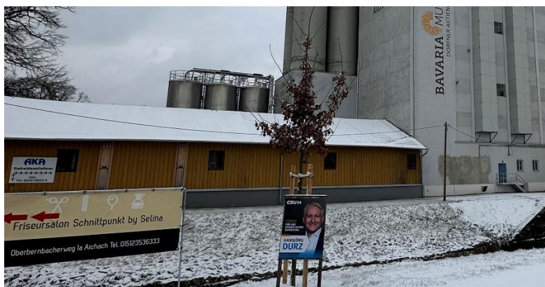
Abbildung 4: Mehlsacklager Ansicht West 14.02.2025
