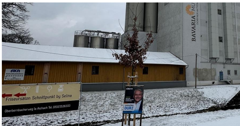
Abbildung 4: Mehlsacklager Ansicht West 14.02.2025
