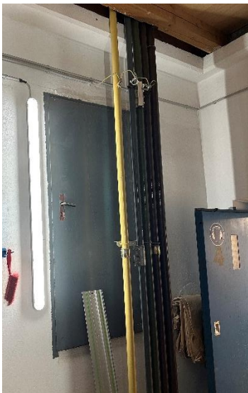
Abbildung 5: Ehemalige Tür im 4. OG zum Kleiesilo
